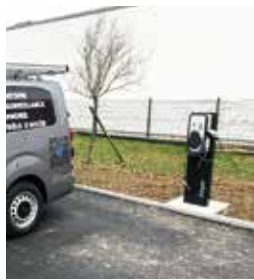
Borne de recharge sur pied pour véhicule électrique
