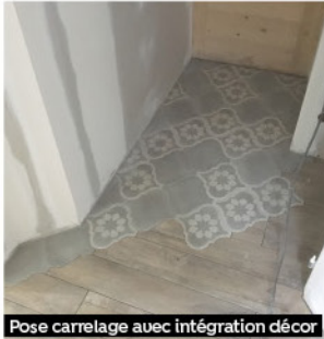
Pose carrelage avec intégration décor
